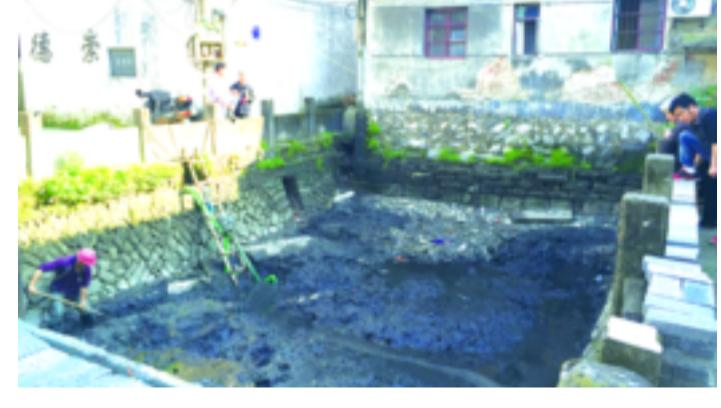
日前,位于天马街道定阳社区里泽祠旁的柳泽塘改造项目正式启动。今年年初,街道结合“清塘美河”工作将该水塘列入重点整改项目,治理周边污染源,并将沿岸生活污水进行统一收集,采用引水换水方式增加水体自净能力。图为4月29日,施工现场。通讯员 厉向军 摄
